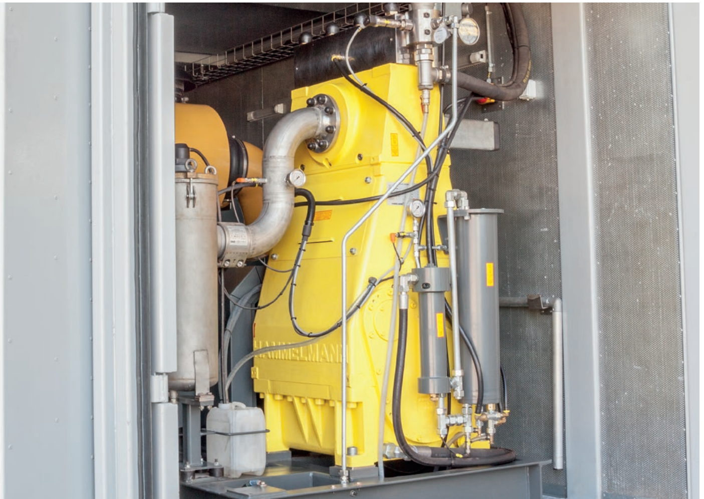
Стационарная установка с дизельным двигателем в шумозащитном контейнере
